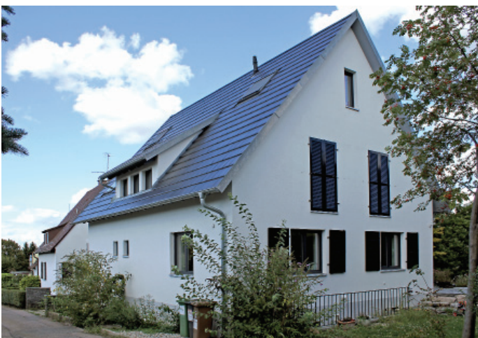
Straßenansicht und Gartenansicht nach der Sanierung: Gauben und Anbau wurden neu errichtet, die Dacheindeckung nach Dämmung erneuert.
