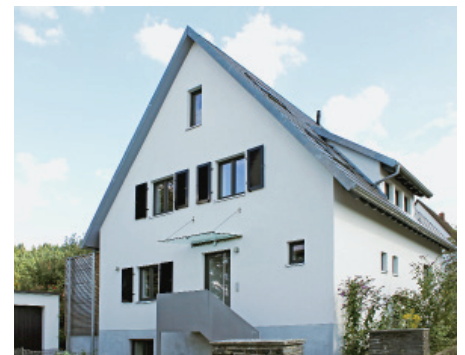
Oben die Straßenansicht mit sichtbarem Wasserschaden vor der Sanierung und danach.
